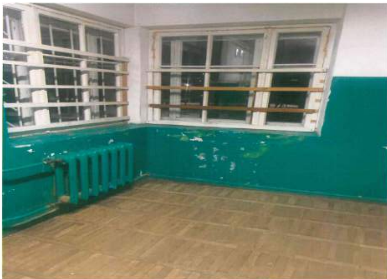
Повреждения отделочных слоев стен
